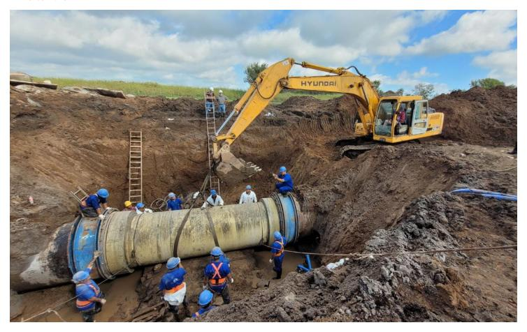
Informamos que han finalizado las tareas de ajuste y control de la nueva pieza colocada en el tramo del conducto que une la Planta Potabilizadora Los Molinos con la Estación Elevadora Sur.
