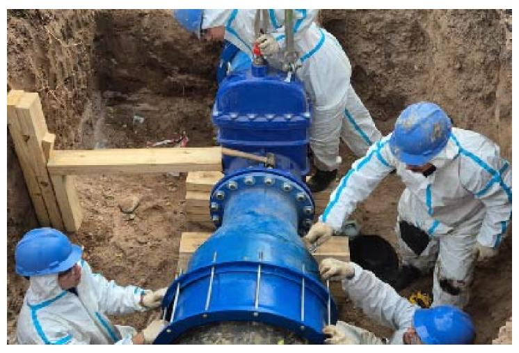
Les informamos que estamos trabando según lo planificado en las tareas de mantenimiento del conducto de 650 mm de diámetro, ubicado en Bv. Los Andes 1600.
